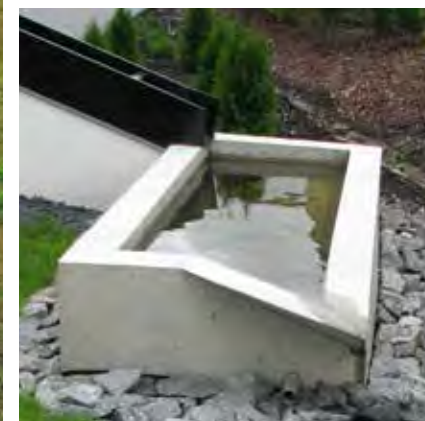
En konstruktionsmässig bassäng för insamling av dagvatten
