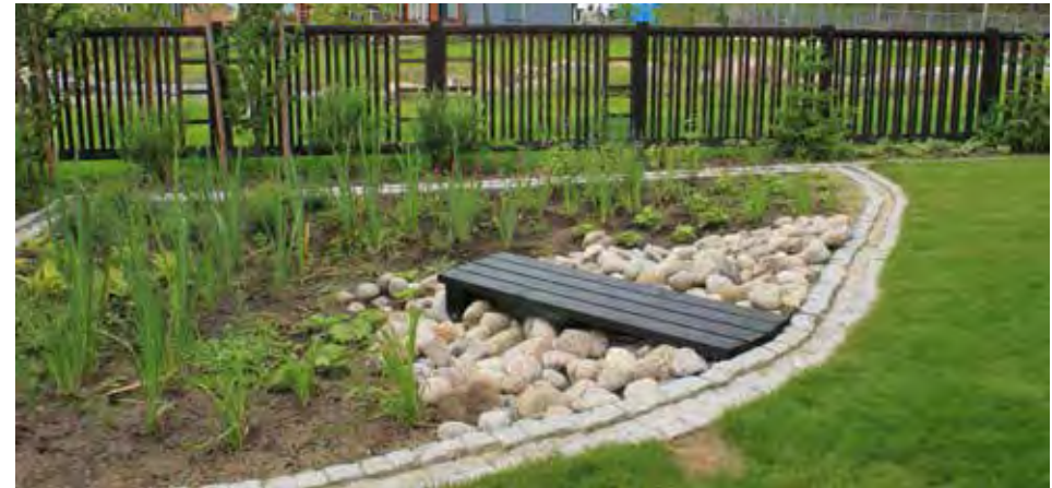
Regnrabatter som planterats för dagvattenhantering.
